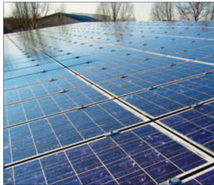
■ La lumière se fait électricité : réalisation d'Issol sur un immeuble en Espagne.
